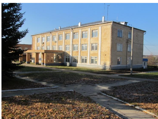
Рис. 1. Административное здание Московской селекционной станции
