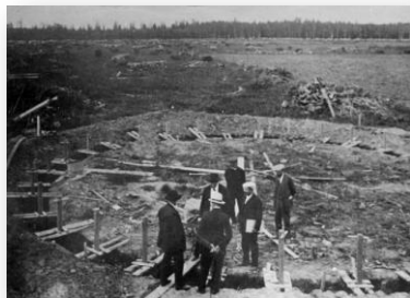
1918 г. Начато возведение водонапорной башни по проекту Шухова
