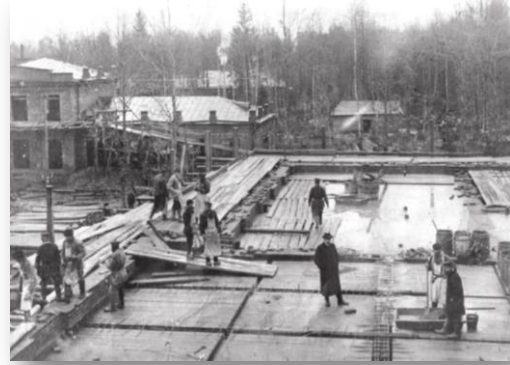
Строительство главного здания. 1914 г.
