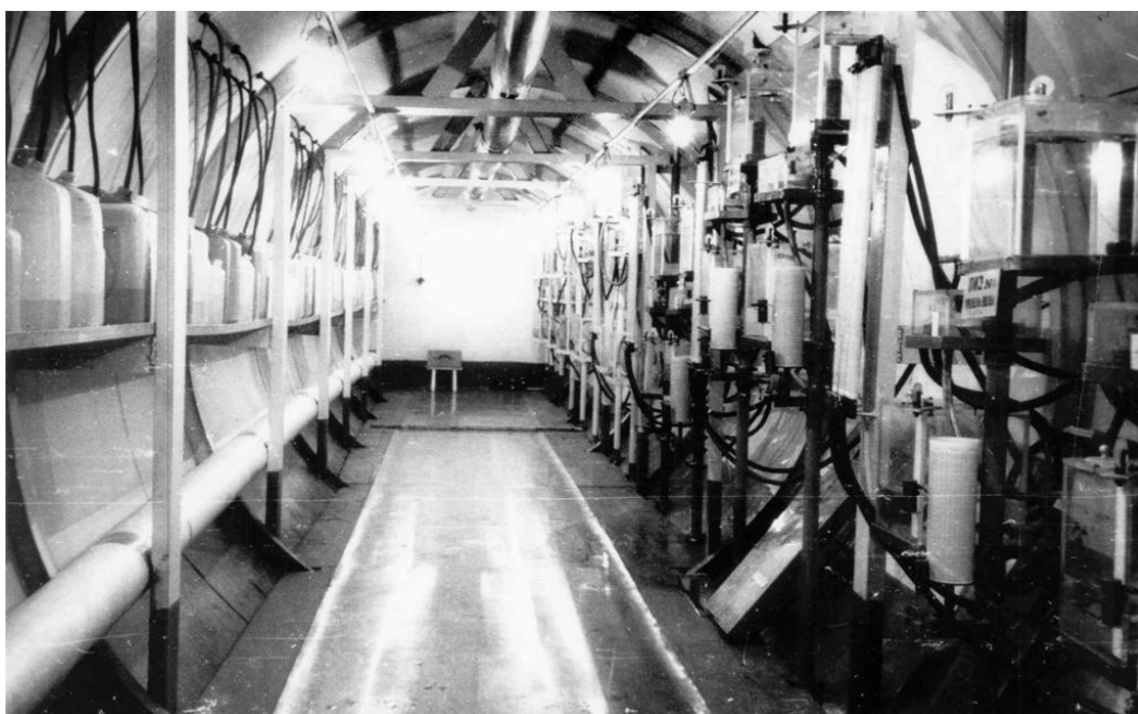
Рис. 3. Подземная галерея (тоннельное помещение) лизиметрической станции
